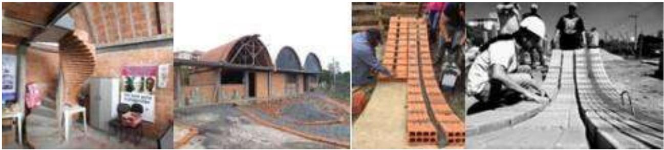
Figura 10 – Obras de edificação do Centro comercial – Parque São Rafael. (a) obra finalizada; (b), (c) e (d) montagem da cobertura de alvenaria armada - Fonte: acervo USINA, 2019.
