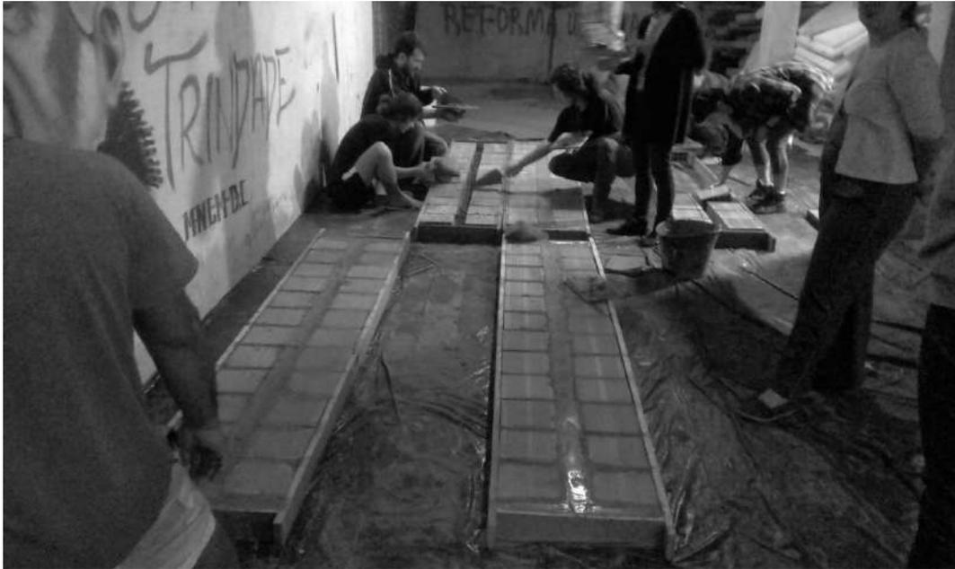
*Figura 9 - Produção de painéis pré-fabricados de alvenaria armada na Ocupação Solano Trindade em Duque de Caxias - RJ - Foto do autor.*
