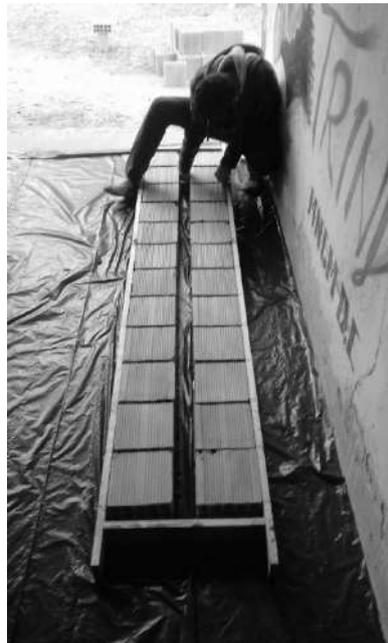
*Figura 8 - Produção de painéis pré-fabricados de alvenaria armada na Ocupação Solano Trindade em Duque de Caxias - RJ - Foto do autor.*
